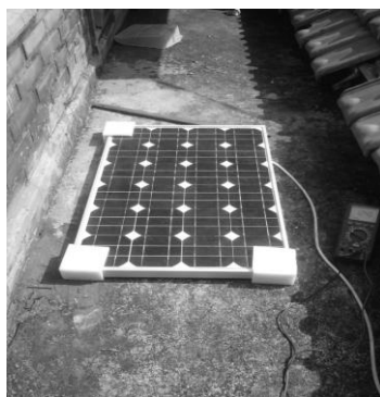
Gambar 16. Penempatan dan Pengukuran Solar Panel
