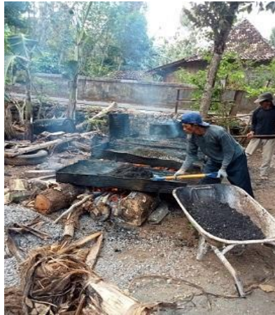
Gambar 7 : Pemanasan Bahan Lapis Keras
